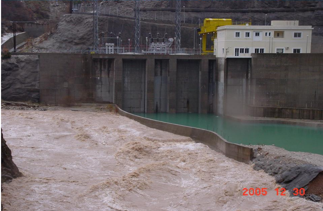
Εικόνα 6.6.3 Εξωτερικός χώρος Υδροηλεκτρικού Εργοστασίου Γλύστρας
