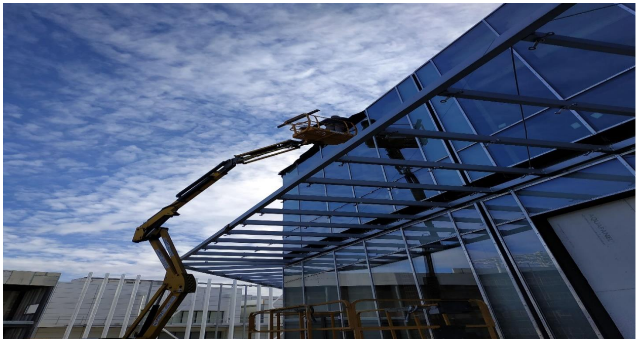
Εικόνα 1.4.4 Ενεργειακοί ανακλαστικοί υαλοπίνακες
