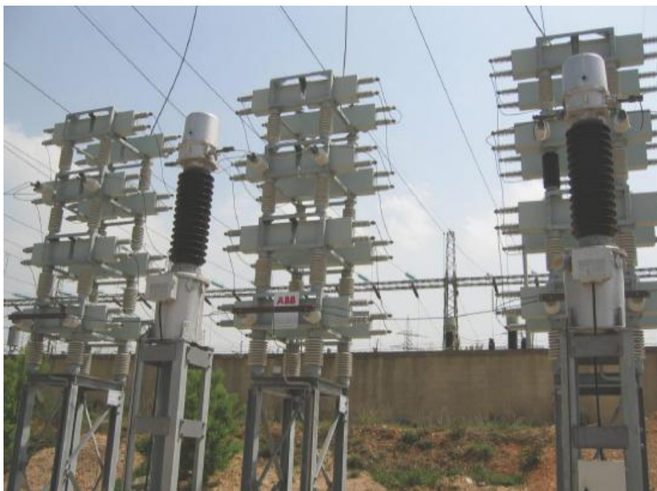
Εικόνα 7-9 Συστοιχίες πυκνωτών
