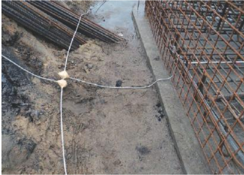
Εικόνα 5-8 Σύνδεση της τανίας γείωσης με το ΣΑΠ
