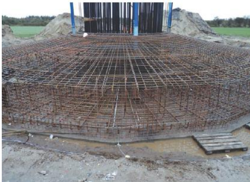
Εικόνα 5-7 Η περιμετρική ταινία στη βάση του οπλισμού
