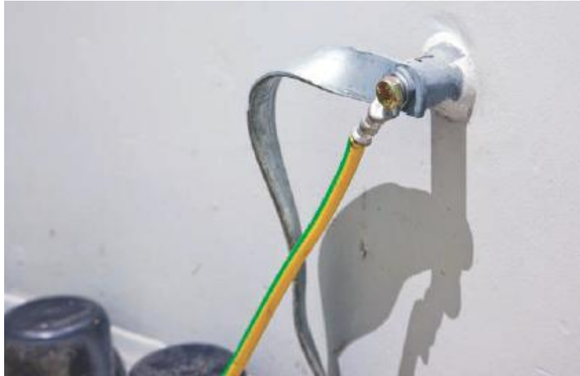
Εικόνα 5-6 Σύνδεση της γείωσης με την ταινία γείωσης
