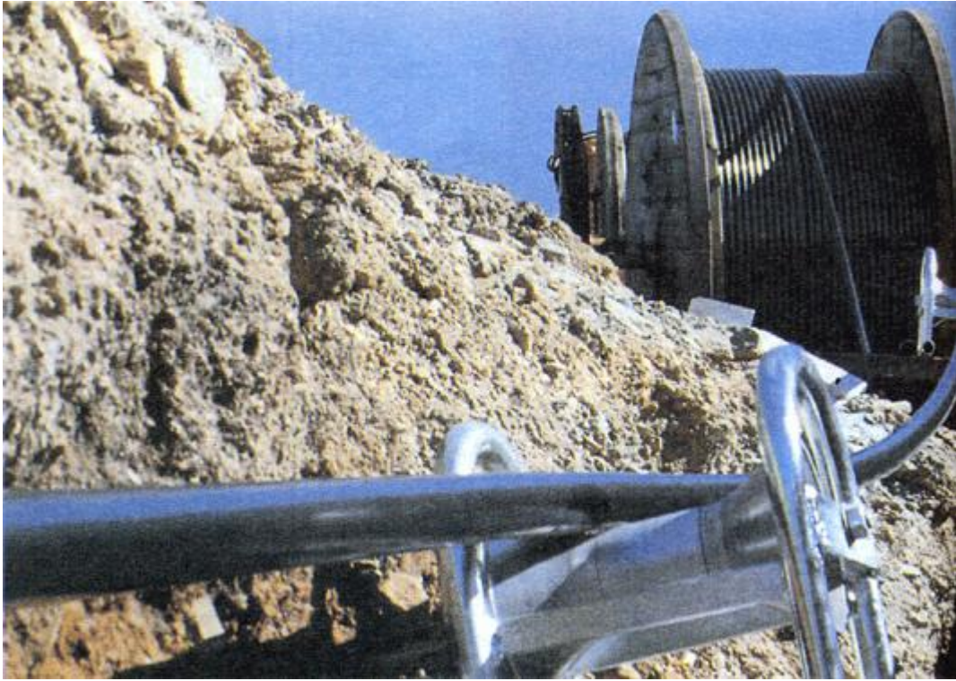
Εικόνα 4-5 Μηχανισμός τοποθέτησης καλωδίων στο έδαφος
