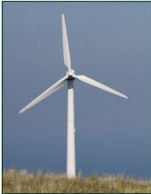
Εικόνα 2-3 Ανεμογεννήτρια οριζόντιου άξονα
