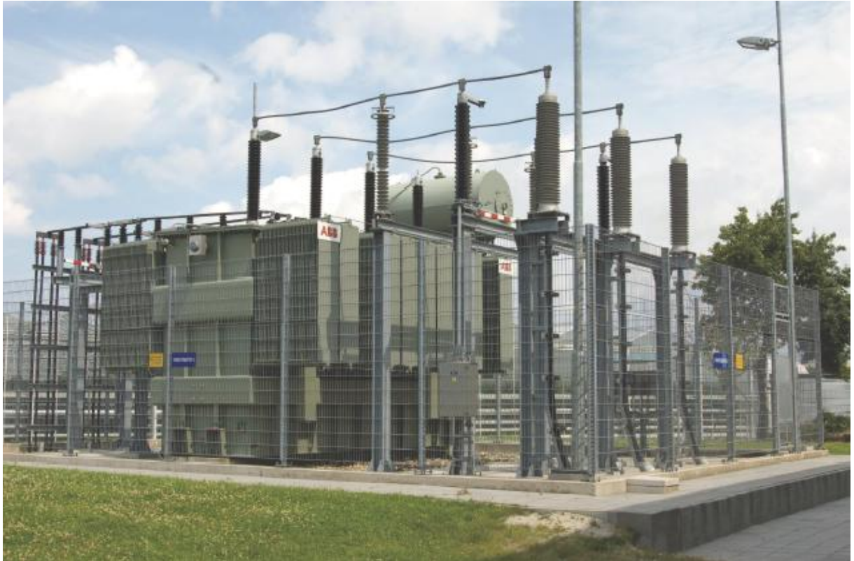
Εικόνα 7-8 Μετασχηματιστής ισχύος
