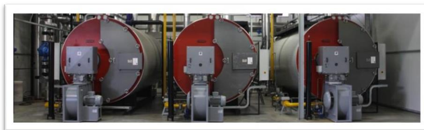
Εικόνα 22: Συμβατικό σύστημα θέρμανσης
