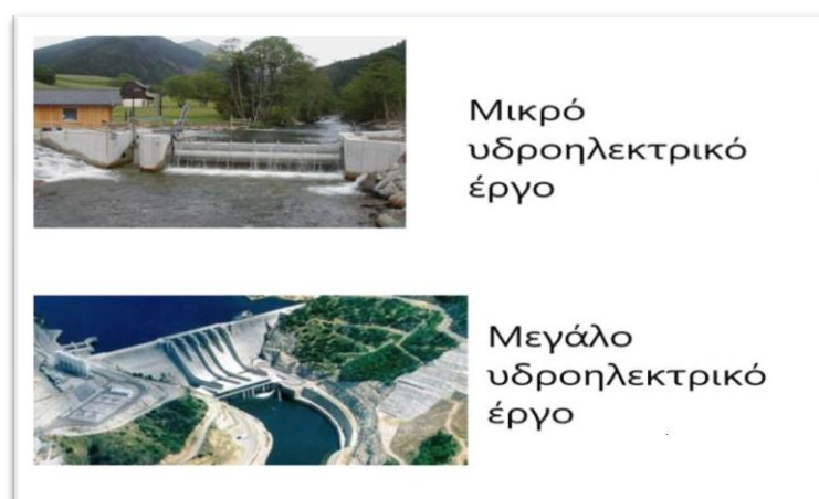
Εικόνα 4: Παραδείγματα υδροηλεκτρικών έργων
