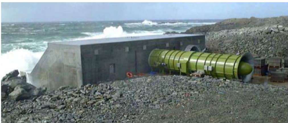
Εικόνα 10. Σύστημα εκμετάλλευσης κυματικής ενέργειας στη νήσο του Islay στα δυτικά παράλια της Σκωτίας.
