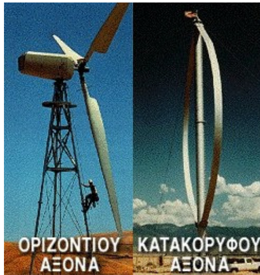
Εικόνα 3: Ανεμογεννήτρια οριζόντιου και κάθετου άξονα
