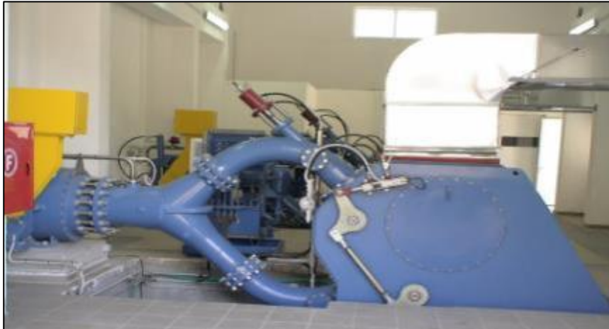
Εικόνα 30:Υδροστρόβιλος τύπου S [Πηγή: Βικιπαίδεια, Είδη υδροστροβίλων]
