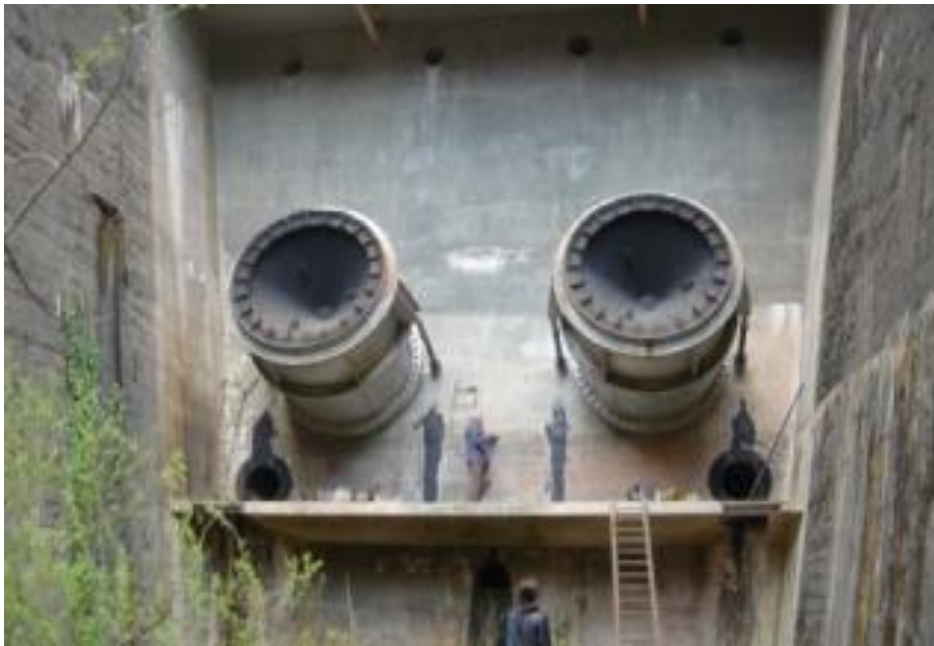
Εικόνα 11:Υπερχειλιστής με σήραγγα [Πηγή: https://estia.hua.gr/file/lib/default/data/15744/theFile ]
