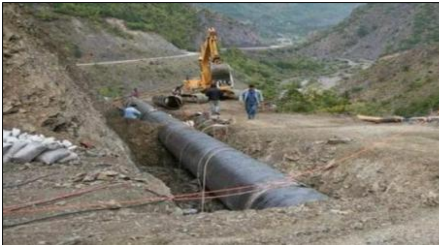
Εικόνα 4: Θεμελίωση του αγωγού προσαγωγής [Πηγή: https://www.castorltd.gr/ ]
