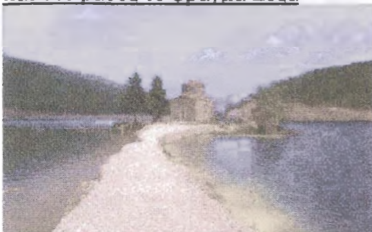
Εικόνα 128: Το εκκλησάκι του Αγίου Φανουρίου μέσα στο φράγμα "Δόξα"
